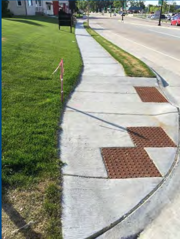
ADA Curb Ramps
